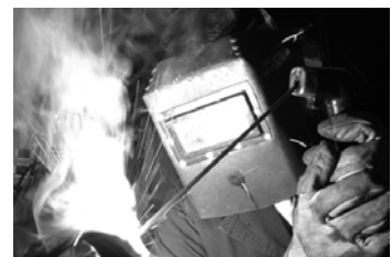
Soldadura per arc
