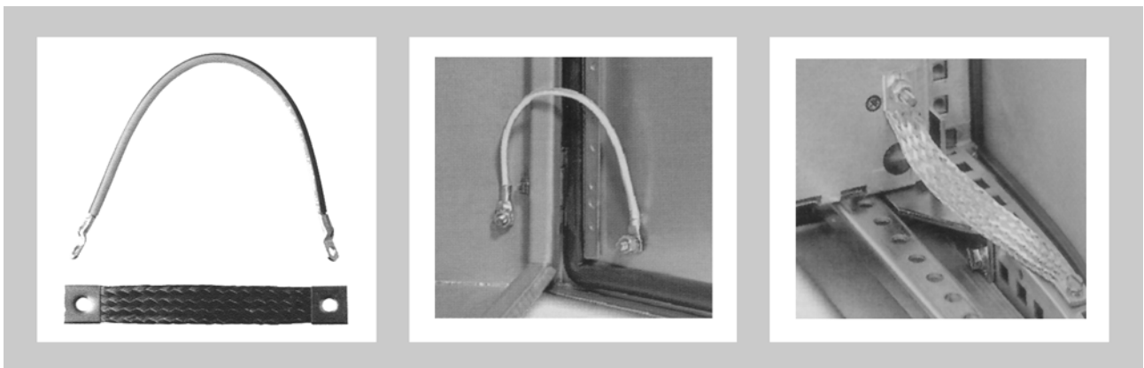
Figura 19. Protecció per continuïtat de les masses
