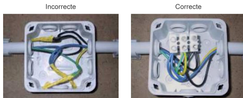
FIGURA 2.7. Empalmament correcte i empalmament incorrecte
