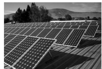
Estructures muntades sobre coberta sandvitx
