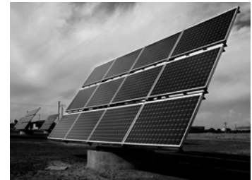
Seguidor solar de dos eixos
