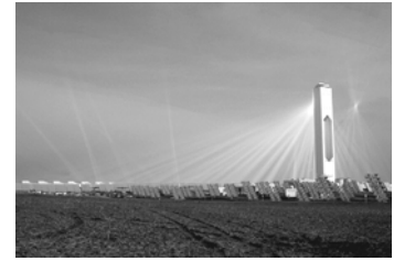
Central termoelèctrica de torre PS10 d'11MW de potència i situada a Sanlúcar la Mayor (Sevilla)
