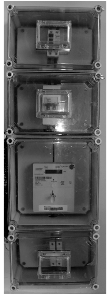
Punt de connexió d'una instal·lació monofàsica
